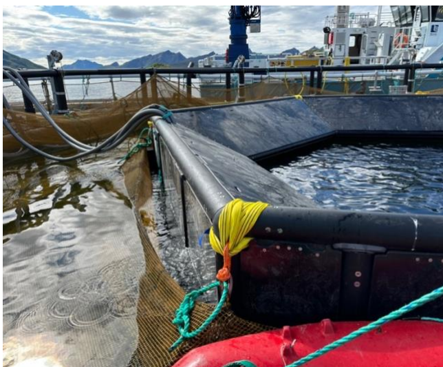
Dokking ferdig montert med 6 stk. 30 cm 18 mm danline «slynge» for å få tak i nottak ved demontering
