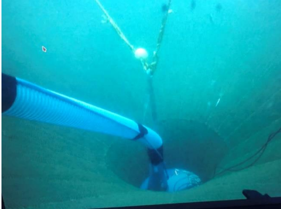
Figur 8. Dronebilde av korrekt LiftUp-plassering i notspiss
