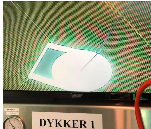
Figur 4. \varnothing 400 PE gjennomføring for fôrkamera inspisert av dykker
